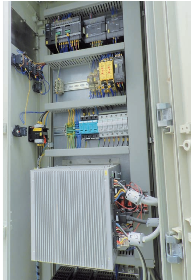
Riadiaci systém robota je prepojený na nadradený systém riadenia plniacej linky.
