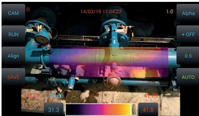
Obr. 3 Aplikácia mobilných IR senzorov a zmiešanej reality na vyhodnotenie teploty objektu [5]
