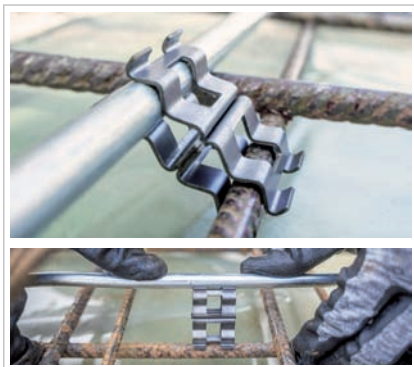
Montáž vodiča FeZn bezskrutkovou svorkou na armováciu konštrukciu jednoduchým nacvaknutím
