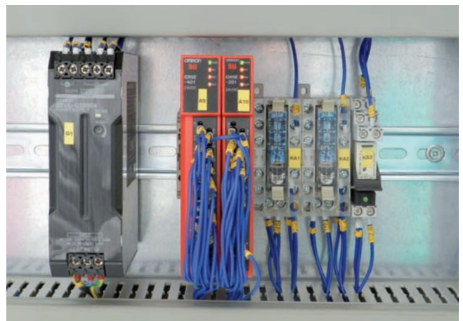
Výstupy bezpečnostných dverových spínačov s blokováním sú pripojené do bezpečnostného relé v riadiacom rozvádzači.
