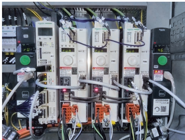
Zložité a presné polohovanie manipulácie s doskami a naloženými paletami na vstupe a výstupe pracoviska brúsenia majú na starosti vysoko výkonný riadiaci systém, frekvenčné meniče a servopohony od Schneider Electric
