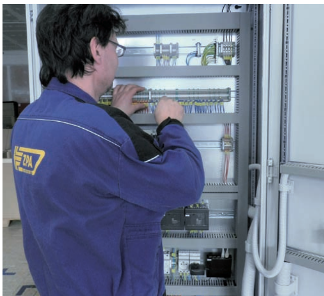
Plánom do budúcnosti je využitie riešenia EPLAN Smart Wiring aj pri výrobe a montáži rozvádzačov.
